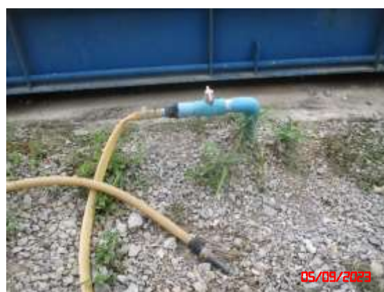
รูปที่ 13 ระบบสเปรย์น้ำบริเวณริมเส้นทางขนส่งแร่และจุดล้างล้อรถบรรทุก
